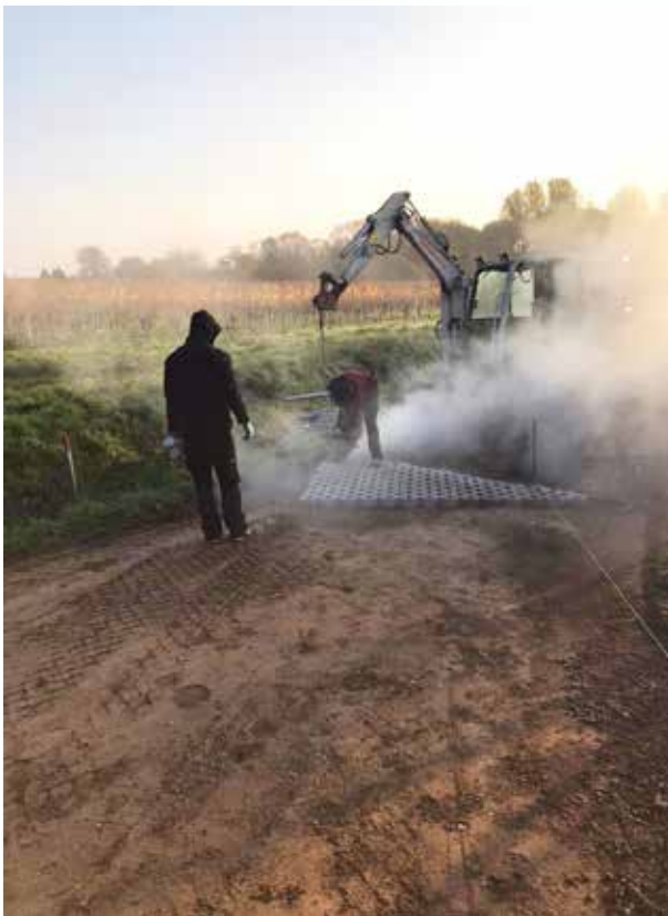
Mise en place de dalles alvéolées sur les chemins au croisement en patte d'oie au lieu-dit Altenberg et le chemin Schaflaegerweg.
