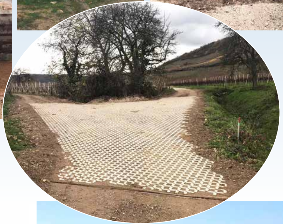
Mise en place de dalles alvéolées sur les chemins au croisement en patte d'oie au lieu-dit Altenberg et le chemin Schaflaegerweg.
