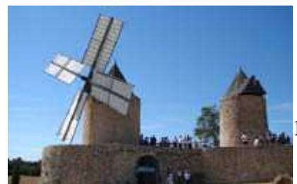
an. Plusieurs fois par an une équipe de meuniers volontaires orientent les ailes au vent dominant, grée les voiles sur les ailes et la magie du vent fait son effet. Le lourd mécanisme démarre, l'arbre en chêne entraîne la grande roue. Les alluchons font vivre la lanterne et la meule tournante se réveille et broie le grain.
