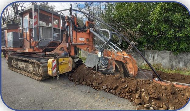
Mais le gros du chantier, attribué à l'entreprise SNATP, concernait la mise en place d'un poste de relevage et d'une canalisation de refoulement sur 850 mètres, afin d'amener les eaux usées jusqu'au-dessus de la station d'épuration. Les tranchées et la pose de la canalisation ont été exécutées en une seule journée grâce à l'utilisation d'une trancheuse, aussi impressionnante qu'efficace, réduisant les désagréments des usagers de la route départementale.
