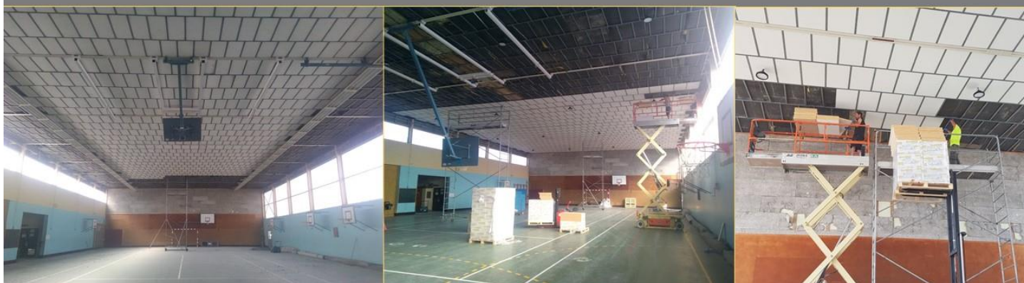
Dépose de l'ancien plafond au gymnase et pose du nouveau ainsi que d'un nouvel éclairage
