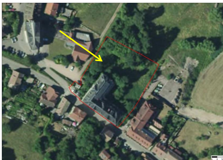
L'ensemble bâti de l'ancienne clinique enserré dans le tissu urbain
