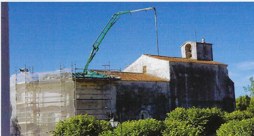
Coffrage et coulage des pinces béton
