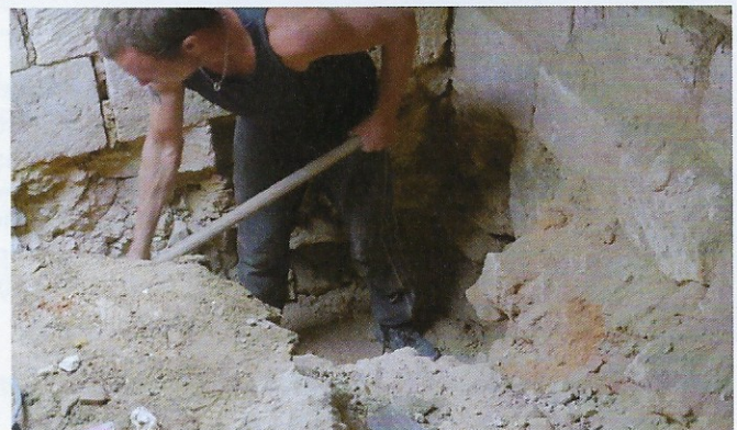
Déblaiement des gravats à la main
