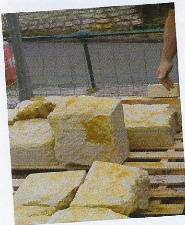
Les pierres ont été déposées et numérotées avant reconstruction
