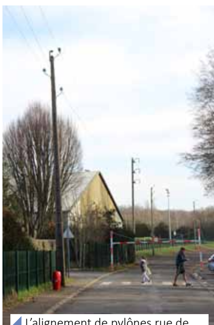
L'alignement de pylônes rue de Nuisement et à travers champ va disparaître. Les câbles seront enterrés.
