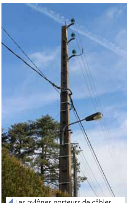
Les pylônes porteurs de câbles télécom et de réverbères resteront en place.
