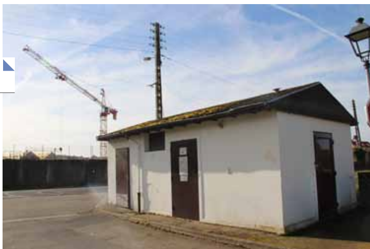
L'intérieur du poste de transformation Guhermont sera modernisé.
