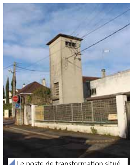
Le poste de transformation situé à l'angle de la rue des Sorbiers et de Nuisement construit sur un terrain privé va disparaître. Il sera remplacé par un poste neuf positionné à l'entrée du terrain de football synthétique, sur le domaine de la commune.
