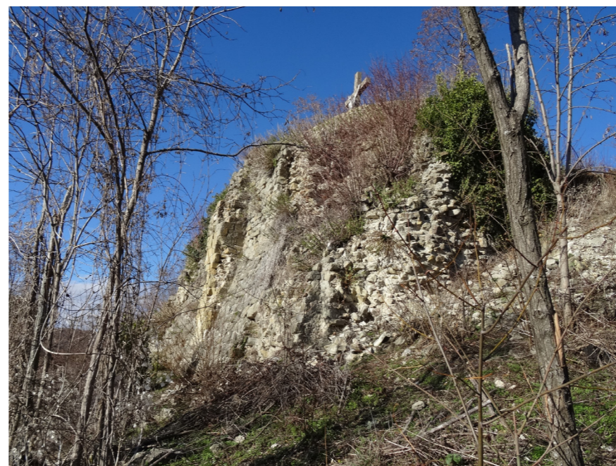
Contreforts maçonnés à dégager visuellement depuis la vision lointaine.
