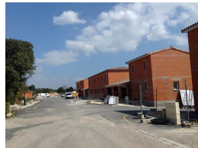
Habitats groupés en construction sur la zone AU de Montjars (Nord-Est)
