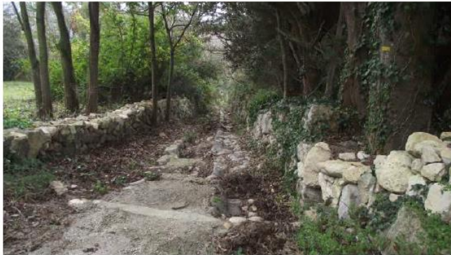
La calade dite « chemin romain » qui descend depuis la Route D 472 jusqu'au Rieu - la calade est encore empierrée et sert de ruisseau pour évacuer le trop-plein d'eaux pluviales lors des orages.
