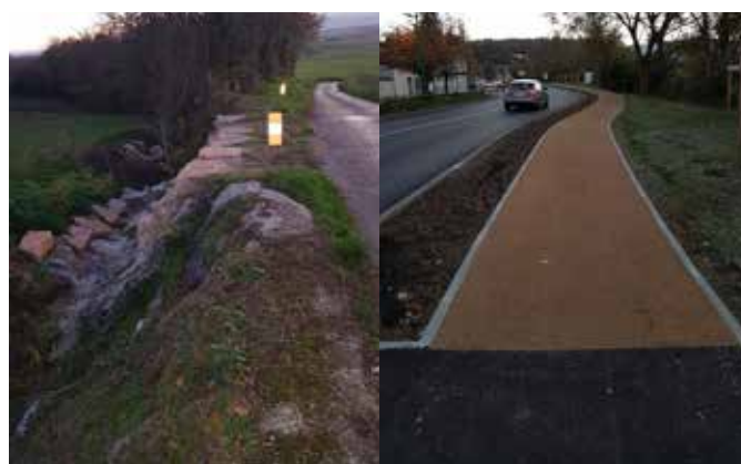
Chemin des Cimes
