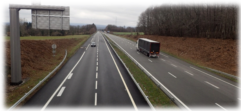
Photo 58 : RN 145 à l'ouest de Saint-Sornin-LeuLac (en haut) et A20 à l'ouest de la commune de Saint-Amand-Magnazeix (en bas)
