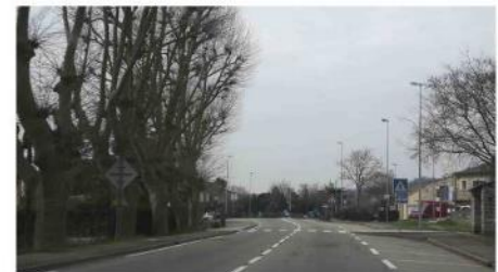
Débouché sur le carrefour giratoire Sud
