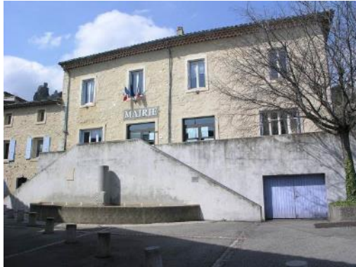
Fontaine et sol bitumé devant la mairie
