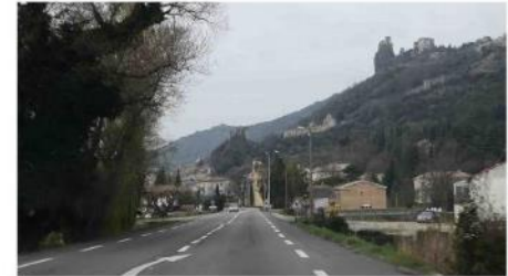
Bonne perception du château, des fortifications, du déperchement du village
