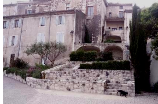
Aménagement en terrasse de qualité
