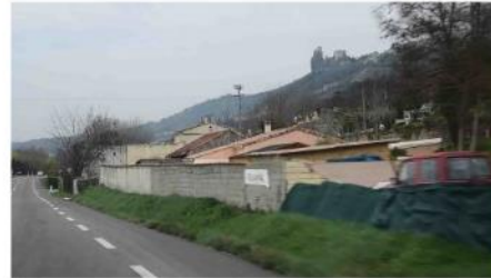
Première vue sur le château
