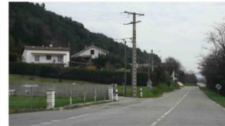
Impact visuel de constructions individuelles surplombant la route et se découpant sur fond boisé
