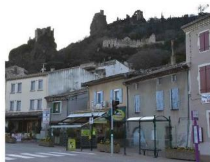
Hétérogénéité en traverse centrale
