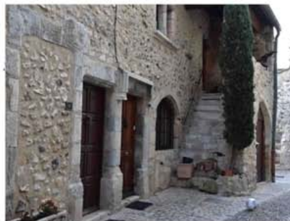
Encadrement des diverses ouvertures en pierres de taille
