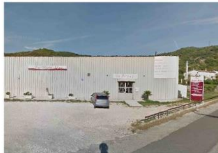
Rue du Perillas
