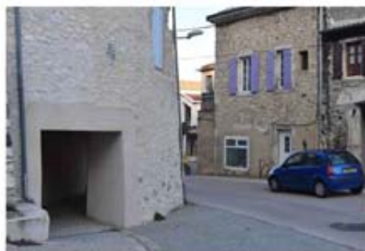
Passage sécurisé le long de l'Avenue du Teil
