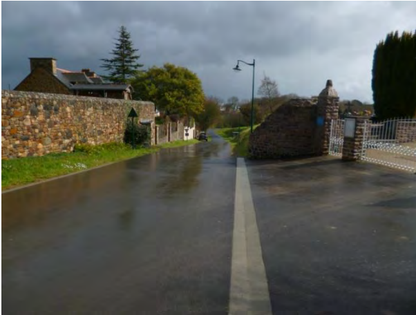
Photos 2 : Passage sous la voirie concernée du Ruisseau de Rambours
