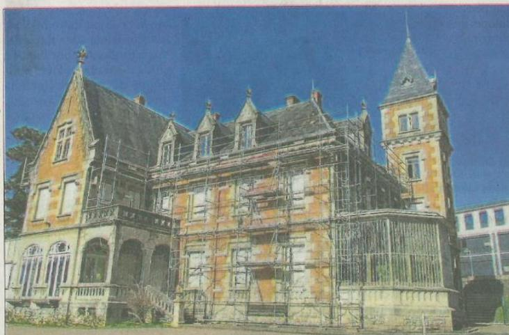
Des travaux viennent d'être exécutés, par l'entreprise Hugonnard, pour les cheneaux et les descentes d'eau de la toiture du château Grammont. D'autres travaux suivront.
