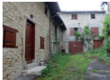
Bâtiments inoccupés dans le périmètre
