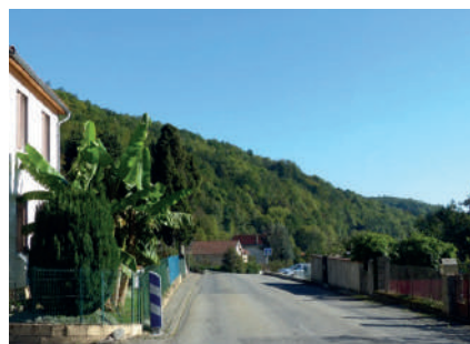
Vue depuis la RD 9 à Montferrier vers la Friche SAB - Etat projeté
