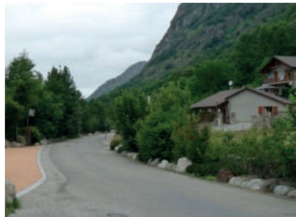
Exemple de mise en place d'une chicane avec réduction d'emprise de chaussée à Orlu
