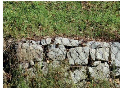
Gabions à maille torsadée, au caractère vieillissant entre Montségur et Fougax-et-Barrineuf
