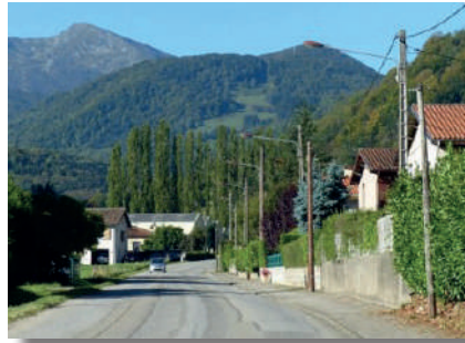
Montferrier : Traversée en surlargeur à récupérer pour les autres mobilités
