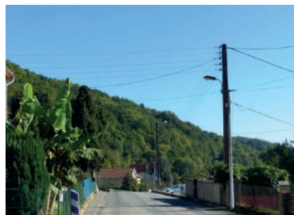
Vue depuis la RD 9 à Montferrier vers la Friche SAB - Etat initial
