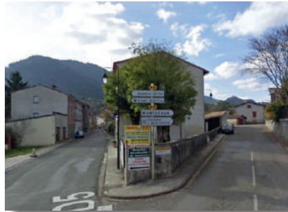
Nécessité d'aménager les carrefours (Fougax-et-Barrineuf)
