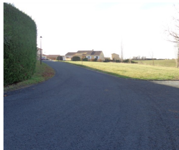
Réfection de la chaussée de l'Impasse du XIII
