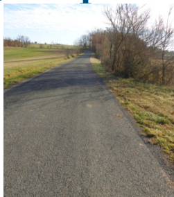
Réfection de la chaussée du Chemin de la Bouriette
