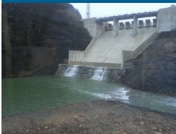
Création du nouveau déversoir du Barrage de Razisse
