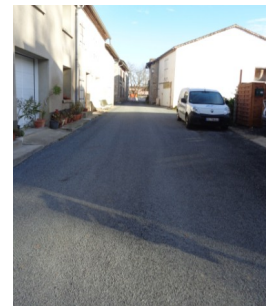
Réfection de la chaussée du Hameau de Grèzes
