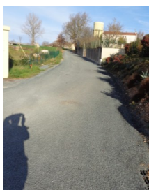
Réfection de la chaussée du Chemin de la Coustette
