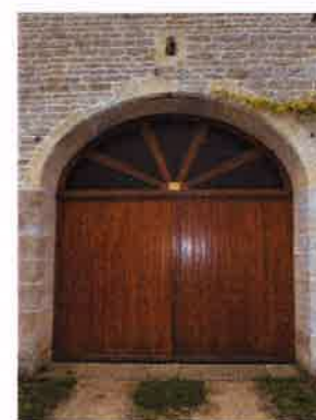
Porte pleine et imposte vitrée - Arc cintré
