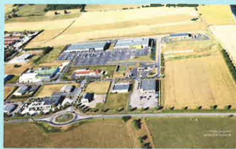
Après la réalisation des travaux (3 ème tranche) sur la ZAC
