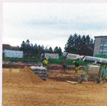
Terrassement tennis couvert
