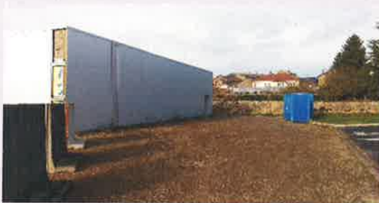
Début des travaux de la Maison de Santé
