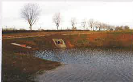
Bassin de rétention des eaux de la ZAC des cailloux
