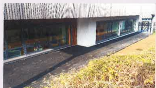
Pose d'un enrobé à l'école des Courlis
