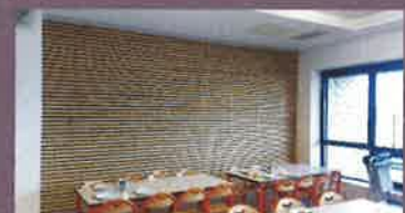
Pose d'un mur d'insonorisation
