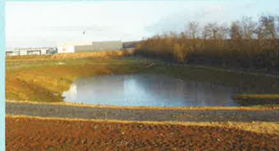
Travaux de création de bassins de rétention sur la ZAC
