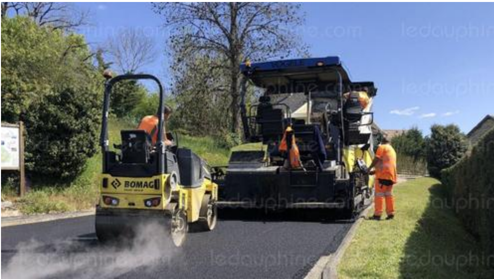
Mercredi, la dépose de la sous-couche d'enrobé était en cours dans la grande rue sans câbles aériens. De gauche à droite : Aurélien Labalte, maître d'œuvre, Clément Ferrand, conducteur de travaux, Philippe Fillod, Pierre De Smedt et Jean-Claude Gengler, élus, représentants de la mairie de Creys-Mépieu.
