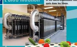
On a éliminé les particules, maintenant on va s'occuper des micro-organismes, bactéries, virus, parasites... On est maintenant dans le très très petit, c'est pourquoi on utilise ce que l'on appelle de « l'ultrafiltration » avec au plus de 350 modules. Dans chacun d'eux, il y a une membrane, sorte de textile constitué de milliers de fibres très fines. L'eau est envoyée sous pression à travers ces modules et les micro-organismes restent bloqués dans les fibres.
