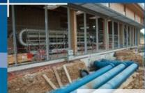
L'eau des forages arrive par trois réseaux différents dans l'usine et se mélange dans une bache de 1300 m<sup>3</sup>. Le traitement peut commencer.
