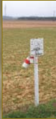
Borne de signalisation du Pipeline Méditerranée-Rhône
