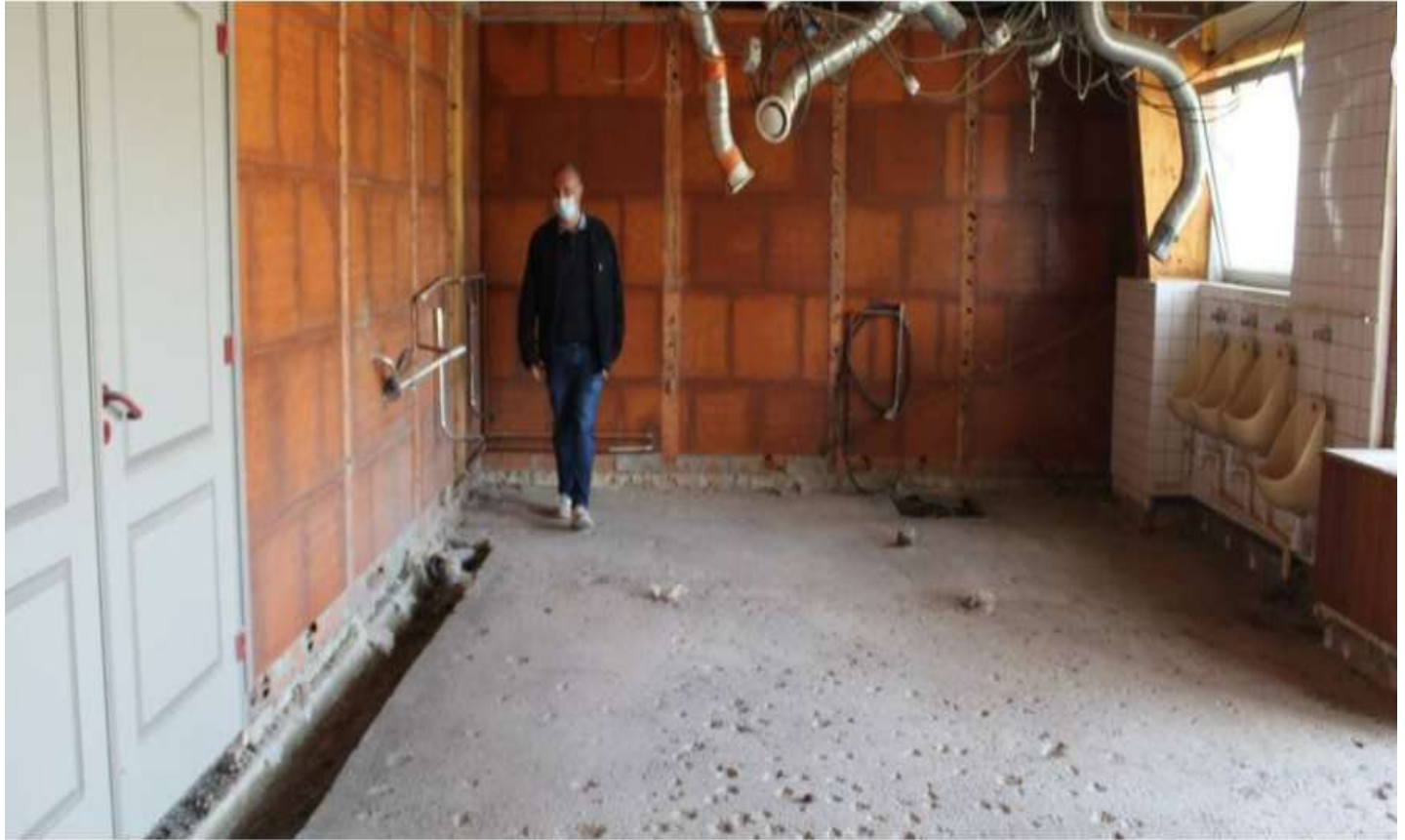
Le hall d'entrée et les sanitaires de la salle Clément-Ader sont en chantier, pour la mise en accessibilité. L'adjoint Pascal Godet a fait un tour de chantier. | OUEST-FRANCE
