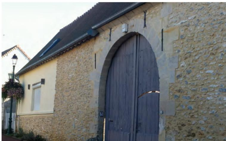
Les façades en moellons calcaires sont les plus courantes sur le bâti ancien d'Agnetz.
