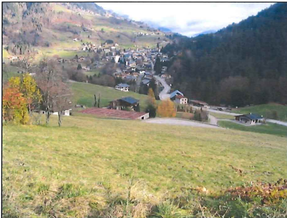
Photo 4 : Marteray « aval » vu depuis l'amont
