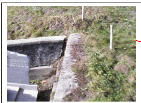
Plusieurs fissures apparaissent sur le mur d'enceinte du cimetière
