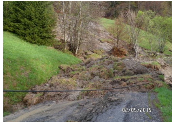
Figure 15 : Glissement de terrain route de Chaucisse
