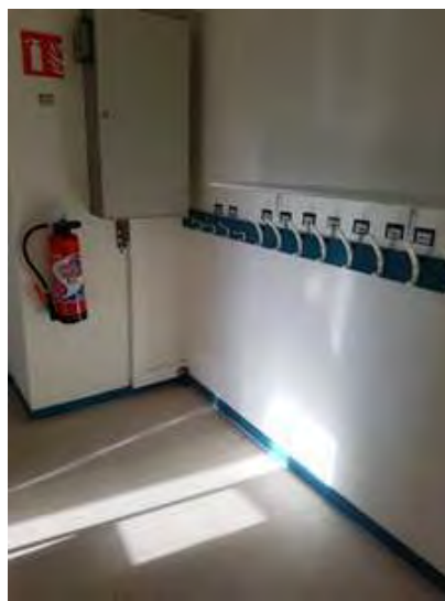
Vestiaires refait du sol au plafond
