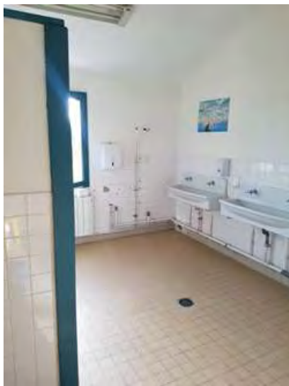
Sanitaires murs et plafonds
