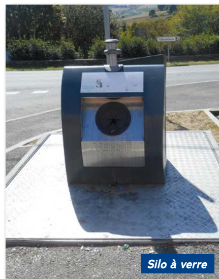
Silos enterrés à l'Arbresle
