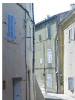
Type projecteur intégré sur façades
