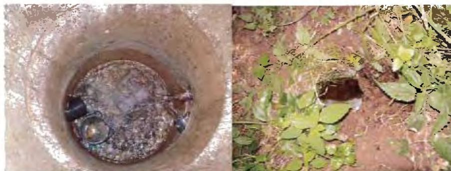
*Figure 14 : photo de gauche : Intérieur du captage : arrivées d'eau des drains A et B, adduction et trop-plein
