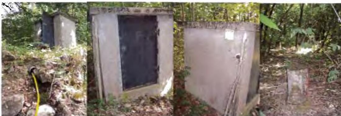
*Figure 6 : Captage de Claudi et plots béton matérialisant le « massif drainant »*
