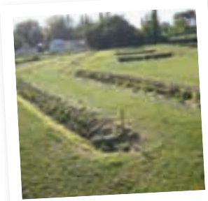
Le terrain d'infiltration (réduit le rejet des eaux dans le ruisseau en période d'étiage).
