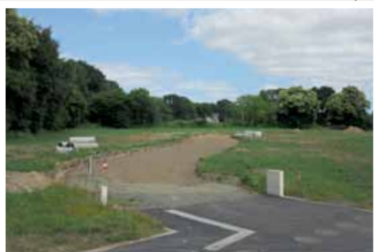
Vue générale sur la parcelle en cours de viabilisation
