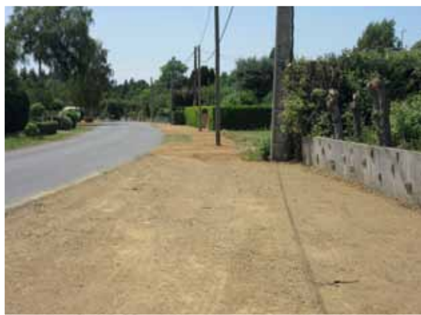
Vue des travaux d'aménagement à Kermilon
