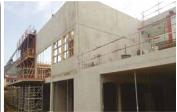
Pose des échafaudages : Le jeu de mécano !!
