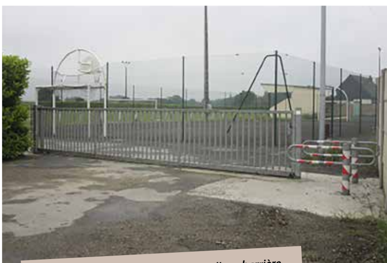
Sécurisation de l'entrée par la pose d'une barrière. L'accès au terrain multisport reste possible
