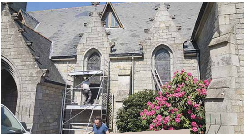
L'entreprise Botrel de Plémy en travaux
