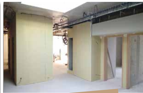
Vue travaux intérieur
