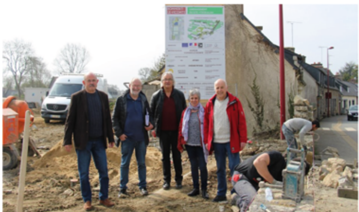
Réunion de suivi du chantier du site Triskalia
