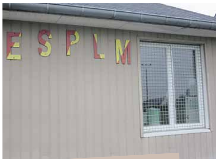
Sécurisation des fenêtres du local
