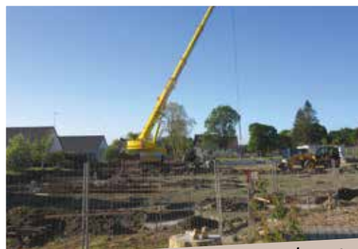
Intervention avec la grande grue pour la pose des longrines
