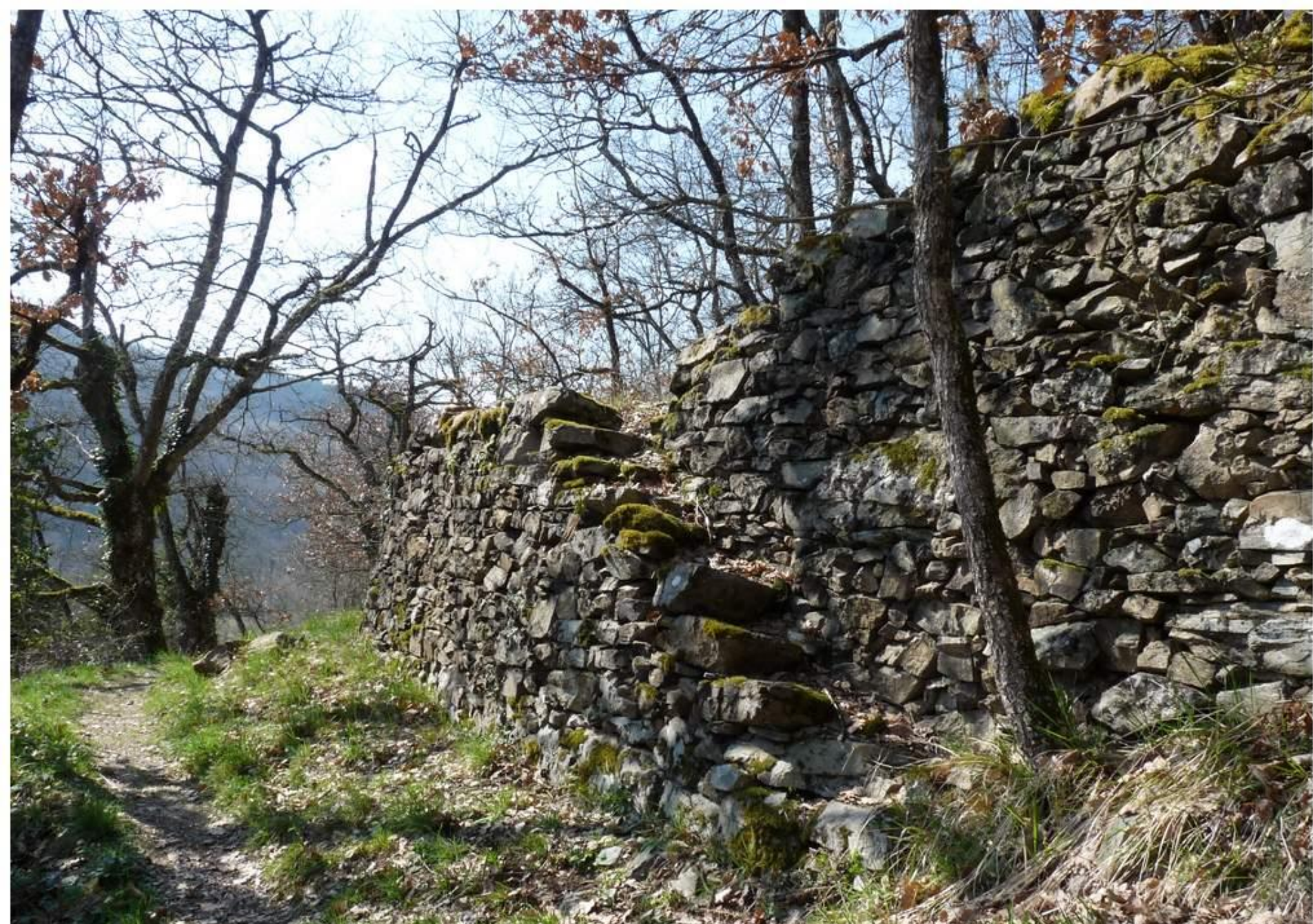
Sur la rive gauche de la Durèze de nombreuses terrasses avec mur de soutènement en pierre sèche. Ces terrasses ont été cultivées avant d'être colonisées par les chênes
