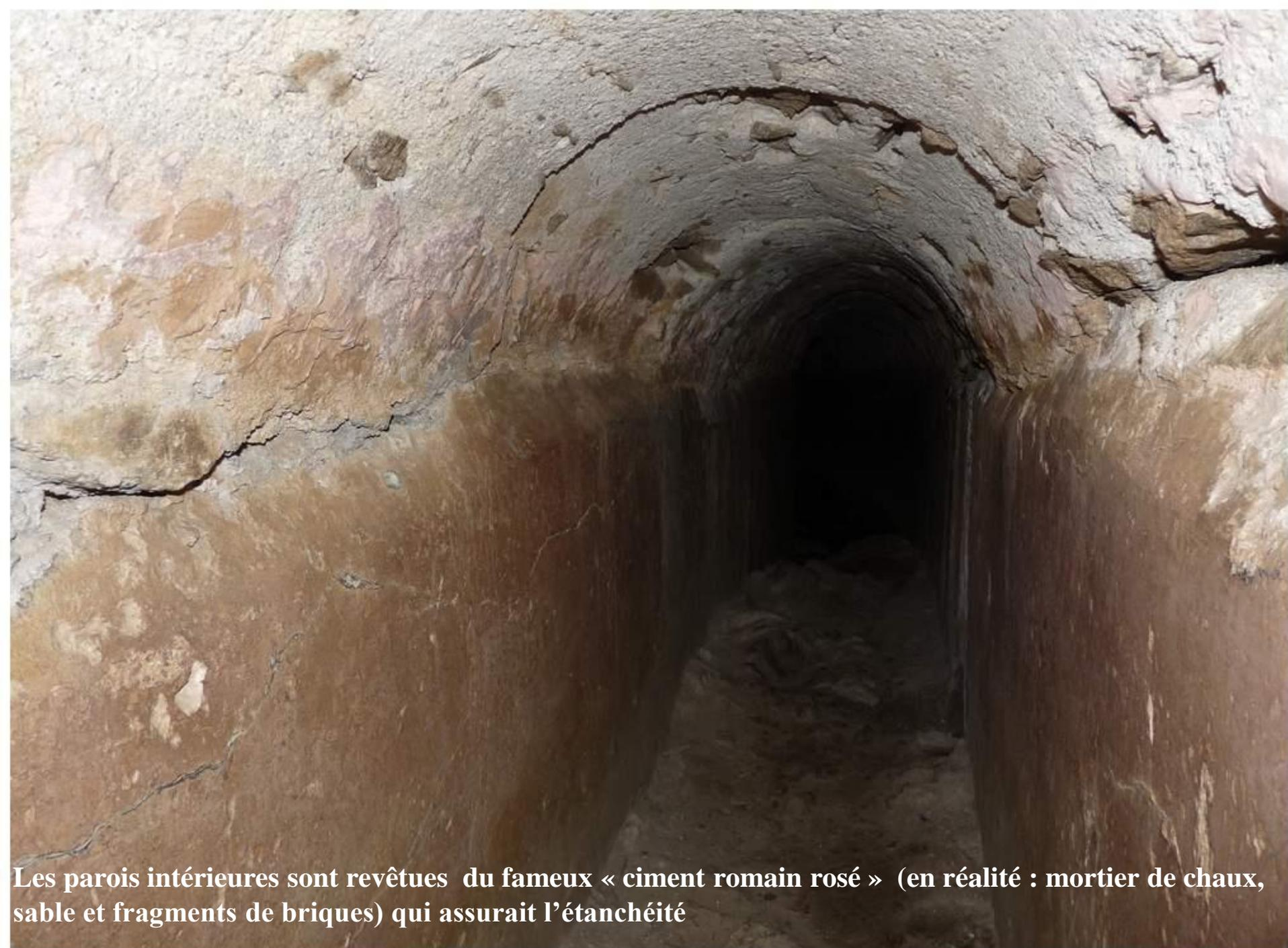
**Les parois intérieures sont revêtues du fameux « ciment romain rosé » (en réalité : mortier de chaux, sable et fragments de briques) qui assurait l'étanchéité**
