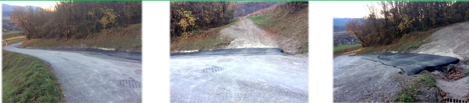
Toujours sur les Grangettes ...sur le parking, la création d'une conduite pluviale évitera l'inondation totale de la voirie. Dans le centre ancien, la chambre de tirage des réseaux télécom a été complètement refaite à neuf accompagnée du revêtement en enrobé.
