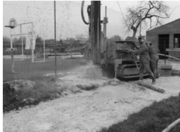
*Forage : profondeur de 28 mètres et eau à 14°C*
