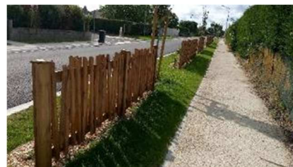
Fin des Travaux RD128 p.07
