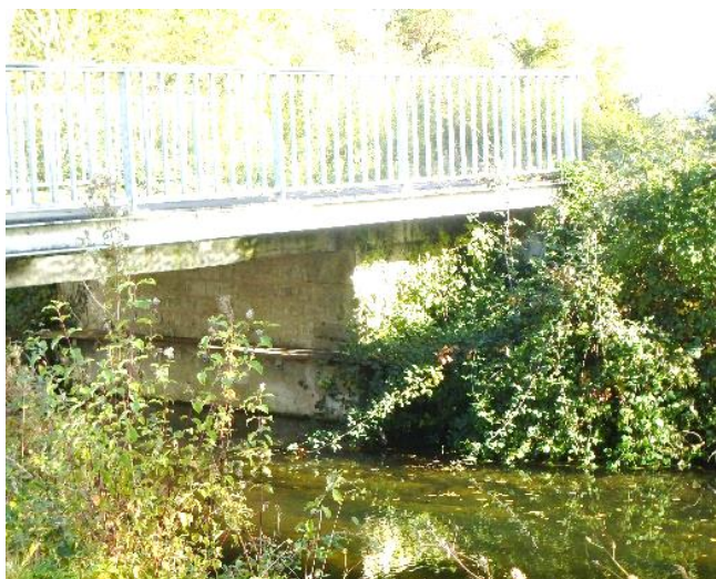
Pont de la Fossade
