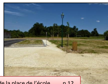
Travaux de la place de l'école p.12
