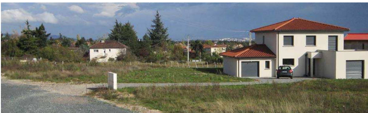
Lotissement en cours de construction au lieu-dit Vallier - Grandes Terres
