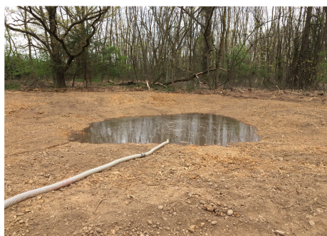
Mise en eau des mares le mercredi 21 avril 2021
