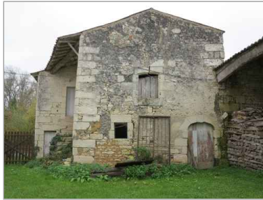
L'un des rares exemples de façade en pignon ; le débord du toit abrite l'escalier extérieur.
