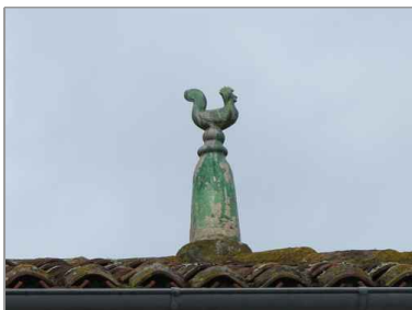
Épi de faîtage en faïence sur la demeure bâtie en 1857, aux Grandes-Maisons.
