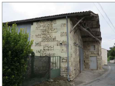
Cette grange-étable présente un avant-toit formant balet et un chaînage d'angle avec pierres de calage.
