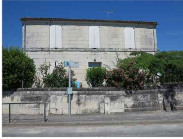
Le logement de l'instituteur de l'école de filles.
