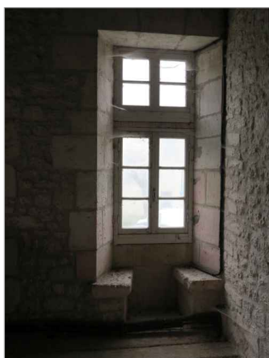
Fenêtre à coussièges de l'ancien logis près de l'église.
