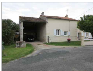
Hangar complètement ouvert en façade et puits commun aux Grands-Maisons.
