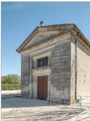
La façade de l'église a été reconstruite au 18 e siècle avec un appareillage en pierre de taille à bossages continus en table (C. Rome).
