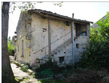
Escalier extérieur à Gâtebourse.
