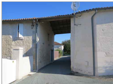
À Guérinerie, la rue passe sous un passage couvert.
