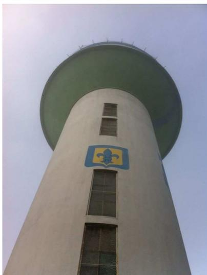
**SIEV : Au cœur du château d'eau.** Construit en 1964 le château d'eau présentait d'importantes fuites au niveau de la cuve. Le Syndicat Intercommunal des Eaux de Verny (SIEV) a donc décidé d'effectuer des travaux de réfection. La reprise de l'étanchéité du réservoir sera terminée vers le milieu du mois de décembre, cette opération est financée par le Syndicat des Eaux de Verny pour un coût de 84 350 €.
