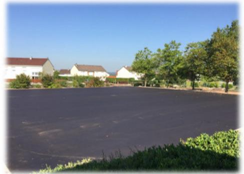
La pose du revêtement final impose plusieurs contraintes. Elle ne peut être réalisée qu'après l'installation du grillage et demande une situation climatique favorable : une température minimale de 12°C avec un minimum d'humidité. Ces conditions seront toutes réunies au printemps.
