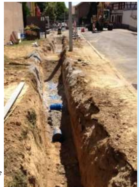
Les réseaux secs - ES, câble et FT - ont été enfouis
