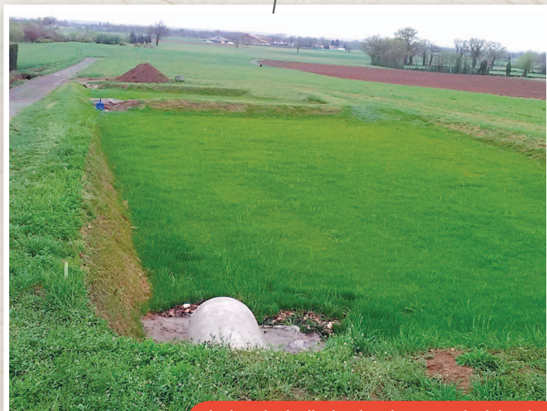
Le bassin de dissipation des eaux pluviales de la rue du Gros Chêne
