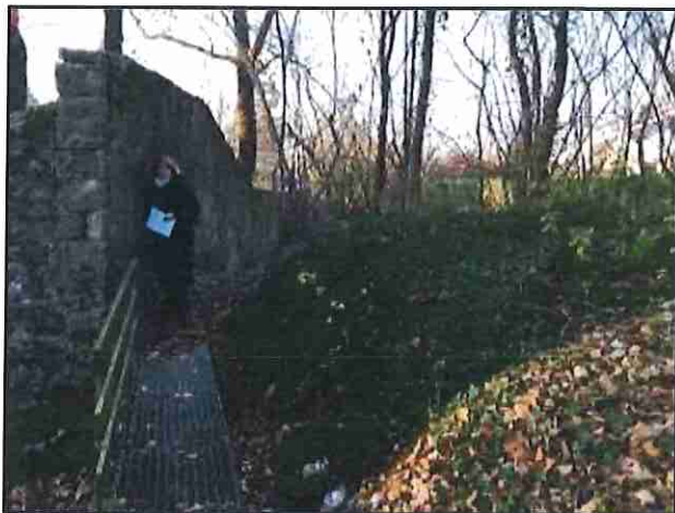
Passerelle métallique piétonne sud
