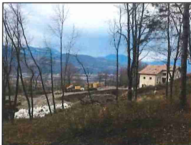
Maison A et excavation maison B - vue vers le sud
