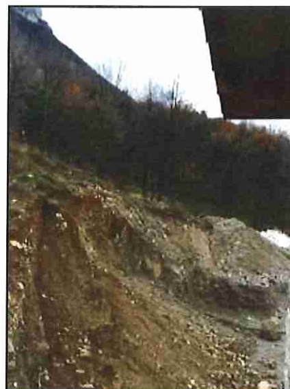
Talus avec excavation - vue depuis Maison A
