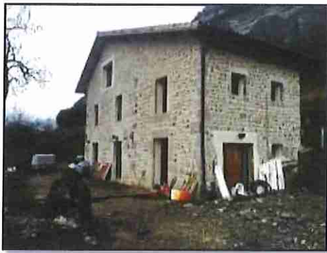
Angle sud est avec réseaux en attente en novembre 2016
