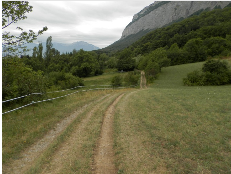
Figure III.3: Tassement du versant en tête du glissement des Viers
